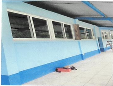
Foto1: Instalación de ventanas de PVC.
