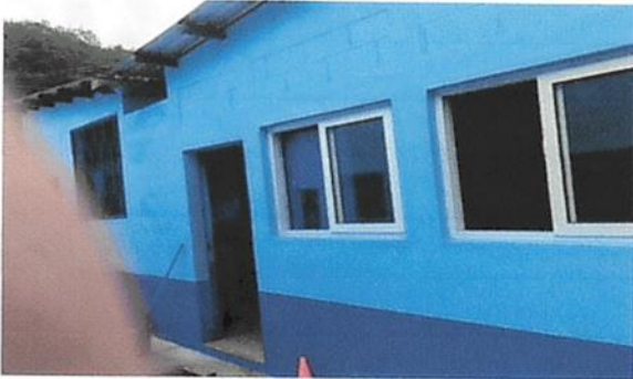
Foto 3: Mejoramiento de instalaciones de cocina y bodega para unificar un solo ambiente entre cocina y bodega.
