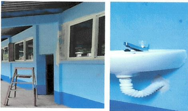
Foto 5: Mantenimiento de baños (sanitarios, lavamanos y accesorios).
