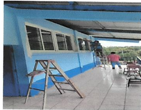
Foto 4: Pintura de exterior e interior de cocina, bodegas y aulas.
