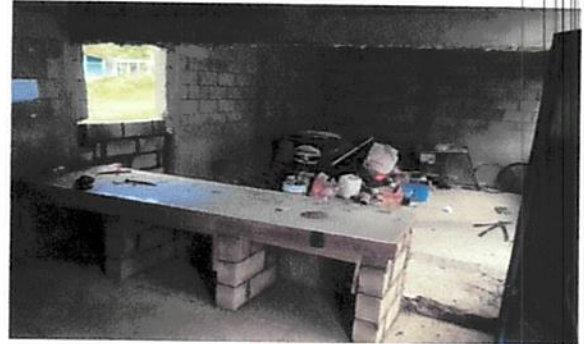
Foto 2: Mejoramiento de instalación de cocina y bodega.
